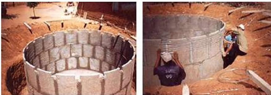
Com as paredes levantadas, o próximo passo é fazer o reboco. O processo deve ser iniciado pelo reboco externo e somente depois deve ser feito o reboco interno. No reboco interno, devem ser utilizadas 3 latas de areia fina para cada lata de cimento. Já para o reboco externo, devem ser utilizadas 5 latas de areia fina para cada lata de cimento.
