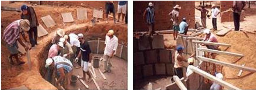
Posteriormente é feita a amarração das paredes. É utilizado arame galvanizado nº 12. A amarração pode ser feita 1 hora após o levantamento das placas. O processo deve ser iniciado pela base devendo todas as voltas de arame ser bem distribuídas na parede da cisterna.
